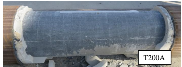
図.7 試験後の内部 PHC 杭の状況
