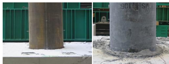
写真.1 試験後の杭体の状況 (NO.3-1)
